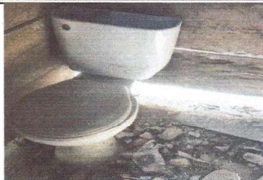
Foto 8: En la siguiente fotografía del establecimiento se está reparando el inodoro
