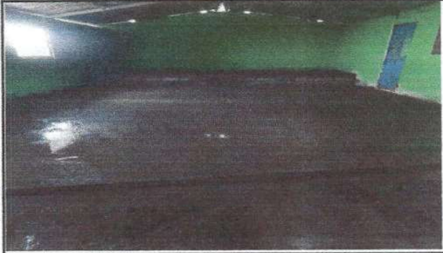
Foto 4: En la foto que se observa que el piso se ha deteriorado, se esta trabajando la sustitución de piso de concreto de cemento liquido.
