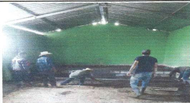
Foto 3: En la foto que se observa la sustitución de piso de concreto de cemento líquido.
