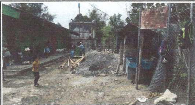
Foto 9: En la siguiente fotografía del establecimiento se muestra los trabajos de reparación de muros perimetrales de tubo hg y malla galvanizada del establecimiento.
